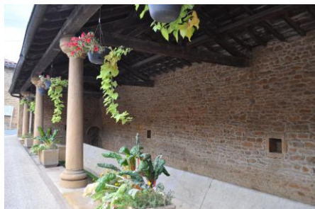
La galerie et l'atelier sont au dos du lavoir
